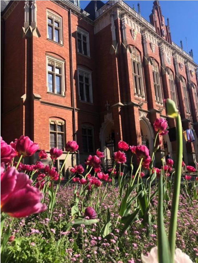
Façade du Collegium Novum de l'Université Jagellonne de Cracovie © Droits réservés Piotr Bitos
